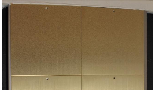
Figure 98 : Vue de détail après nettoyage par projection d'abrasif végétal (passage 30°)
