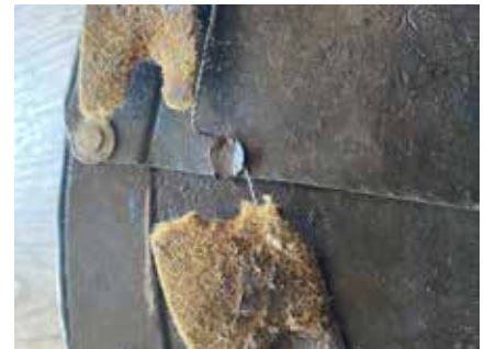
Fig. 3 : Câble métallique utilisé pour maintenir les lames à la place des cuirs rompus. ©HE-Arc CR, 2022
