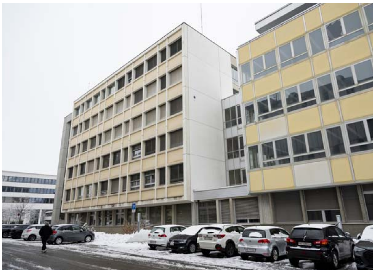
L'espace entre les deux bâtiments sera comblé, et les places de parc seront supprimées pour créer une esplanade paysagère. LUCAS VUITEL
