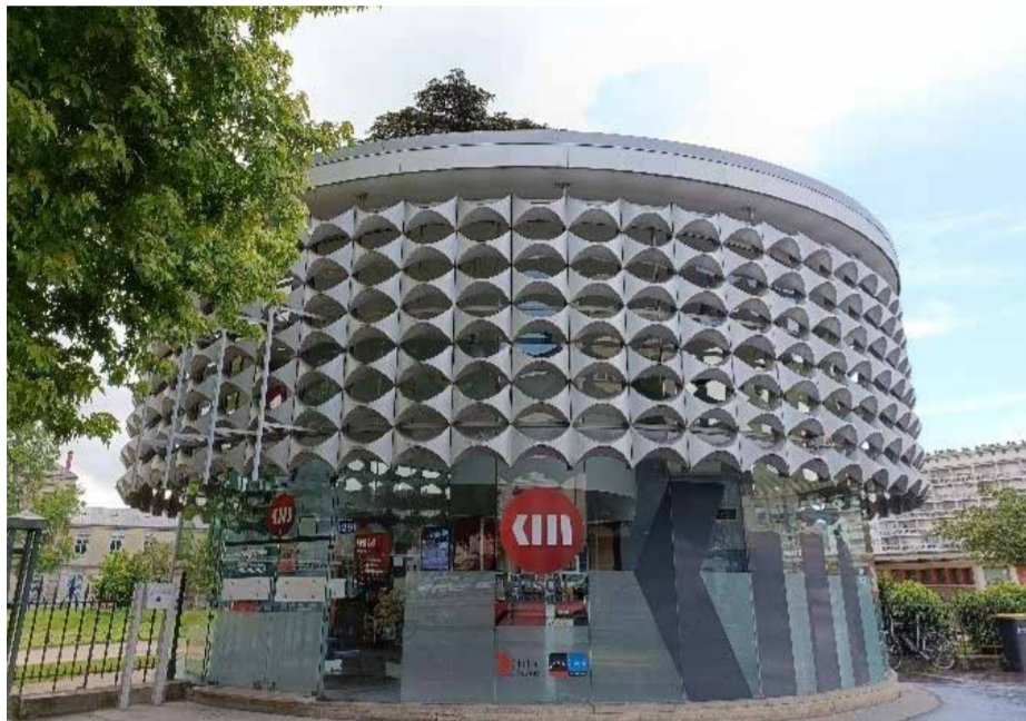
Fig. 1 : Bardage en bacs Luna du kiosque multimédia de Chalons-sur-Saône, © Christian Degriigny 2024.
