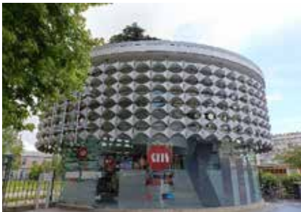
Fig. 1 : Bardage en bacs Luna du kiosque multimédia de Chalons-sur-Saône, © Christian Degrigny 2024.
