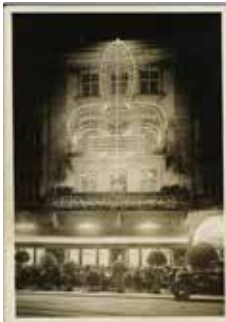
Fig. 1 : Façade Nord de l'Hôtel de la Fleur-de-Lys pendant les années 1930, où était accrochée l'enseigne. ©Bibliothèque de la Ville de La Chaux-de-Fonds
