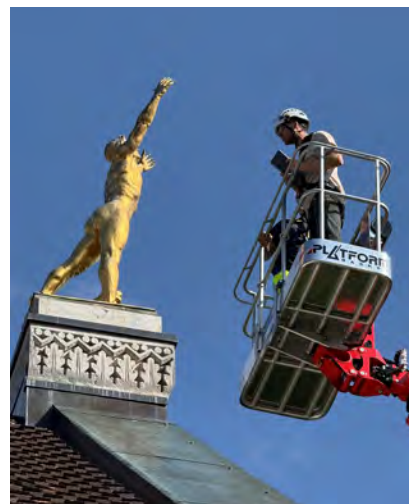
Vers l'idéal, constat d'état d'une statue en bronze du crématorium de La Chaux-de-Fonds.
