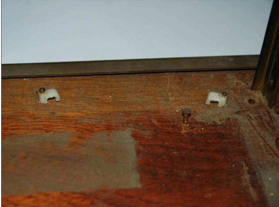
Image 1.79 : Détail de la fixation des câbles, cabinet de l'horloge Vachey
