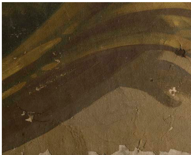
Detail eines Wandgemäldes mit Malschichtlockungen und bis auf den textilen Bildträger reichenden Fehlstellen. (untere Bildkante = 20 cm)
