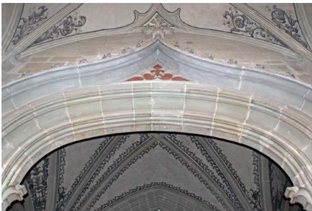
Das ehemalige Südportal des Berner Münsters vorne im Bild, dahinter das Seitenschiffgewölbe von 1454
