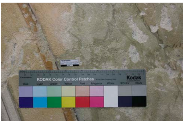
(Abb.1) Villa Patumbah: Gelbverfärbte Retusche in grün hinterlegtem Dekorationsfeld
