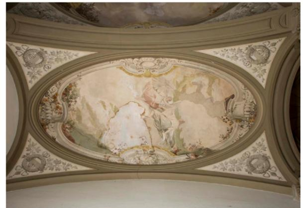
Aufnahme der ersten Kuppel; Darstellung zweier weiblicher Figuren. Von der Mitte bis zum unteren Kuppelrand zeichnet sich der wassergeschädigte Bereich ab (Richter 2013).
