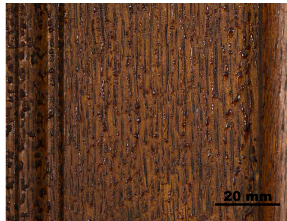
Inselbildung des Überzuges auf einem Eichenfries im Esszimmer.
