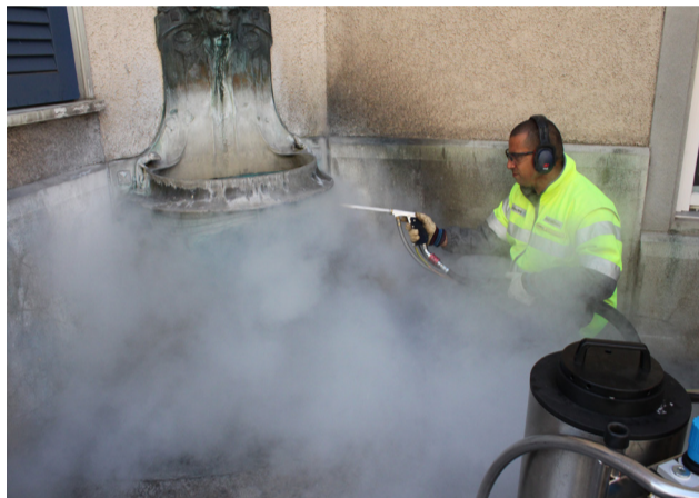
Fig. 2: Tests de nettoyage in situ sur la fontaine de Zürich. La projection prolongée de glace carbonique sur le monument provoque un nuage de fumée..
