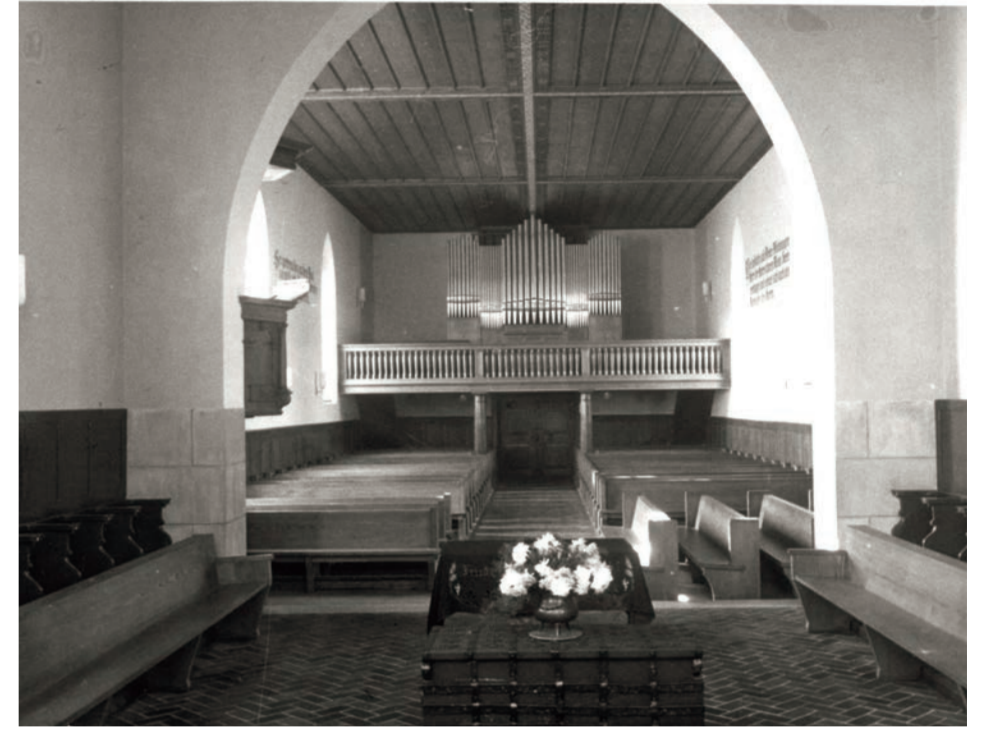
Der Innenraum der Kirche um 1934. Blick vom Chor ins Schiff. (Denkmalpflege des Kantons Bern 1934, o.A.)
