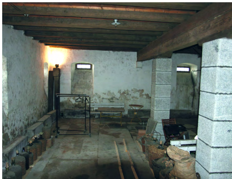
Ansicht des ehemaligen Weinkellers nach den Räumungsetappen der Kantonalen Denkmalpflege und des Archäologischen Dienstes Zürich. Blick auf Süd- und Westwand.
